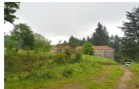
Vue sur la corps de ferme et le chemin qui borde la zone
