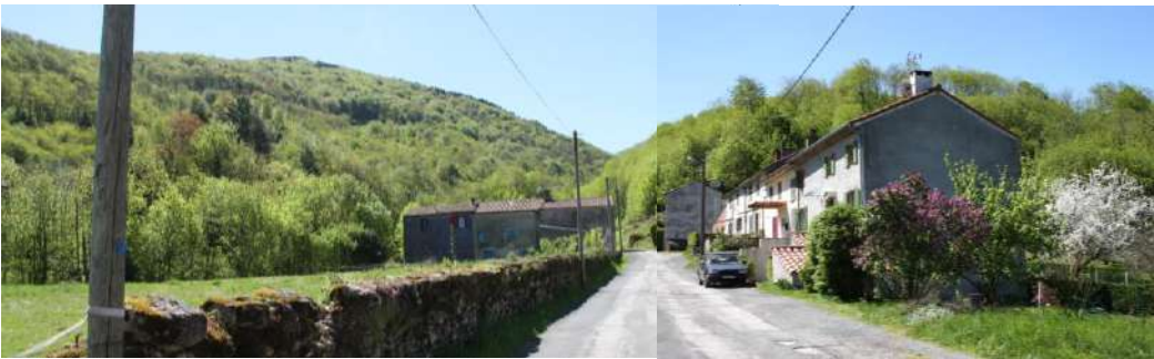
Vue du bâti ancien du cœur de hameau et à gauche du terrain
